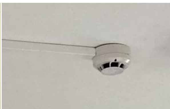
Tête de détection incendie des logements
